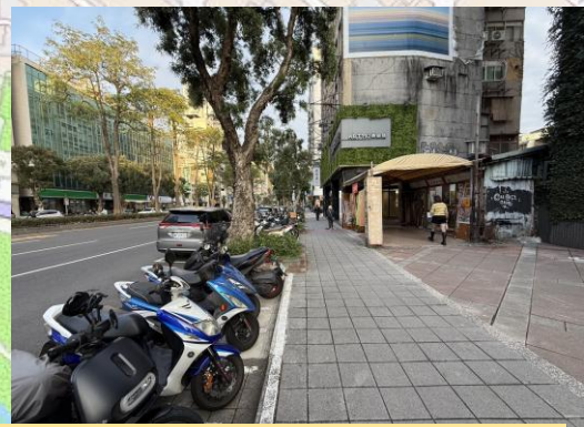
和平東路改善後現況
