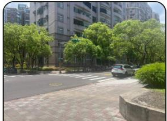
康寧醫院-樹木移植及斜坡道順平
