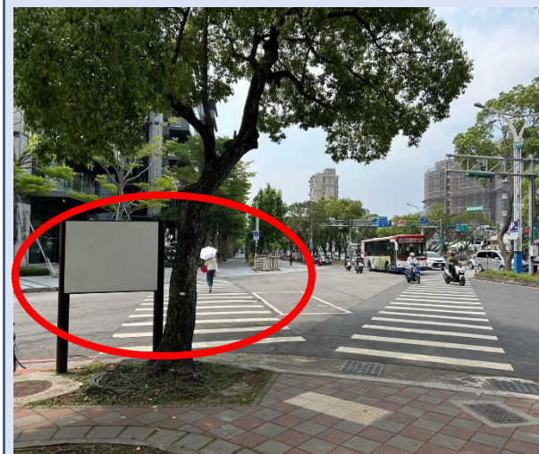
改善前 (福林路及中山北路四段交叉口，告示牌遮擋行穿線)
