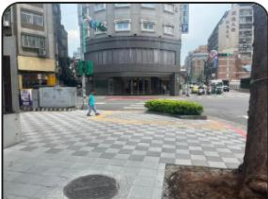
臺大醫院北護分院-鋪面改善
