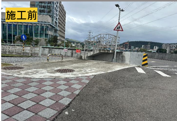
北投區建德橋西北側
