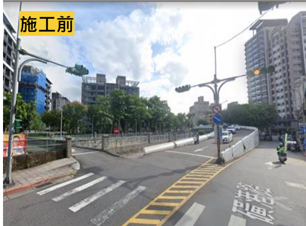
北投區延壽橋(公館路92巷)(磺港路至 公館路92巷)
