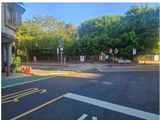
增繪行人穿越道線彩色標記 (詔安街38巷街口)
