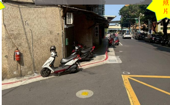
施工前 萬華區環河南路2段250巷5號 -15號人行道更新工程
