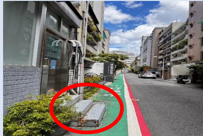
大安路一段101巷1號佛牙昌牙醫診所旁私設階梯(改善前)
