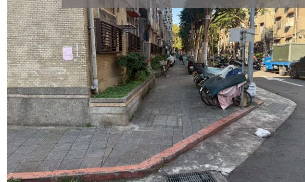
施工前 萬華區大理街160巷21弄華昌國宅基地南側
