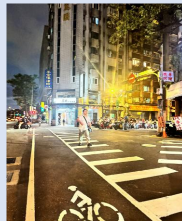
林森南路145號車行地下道出口增設附掛燈-施工後
