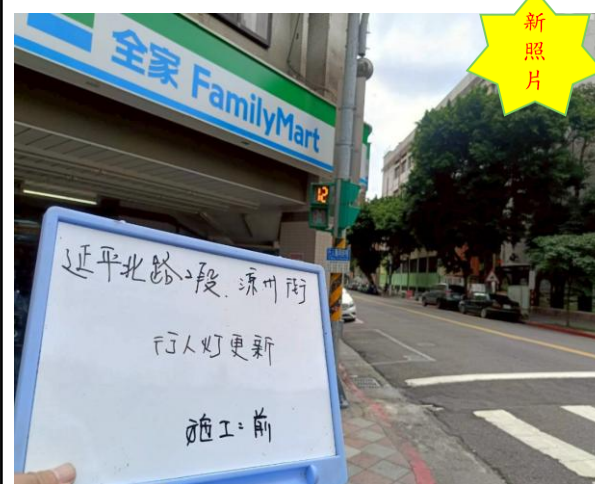
大同區延平北路2段 與涼州街口
