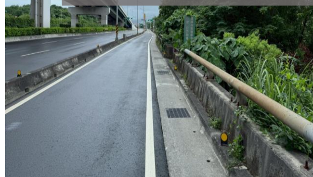
施工前 北投區大度路(全線汽機車分隔島兩側)
