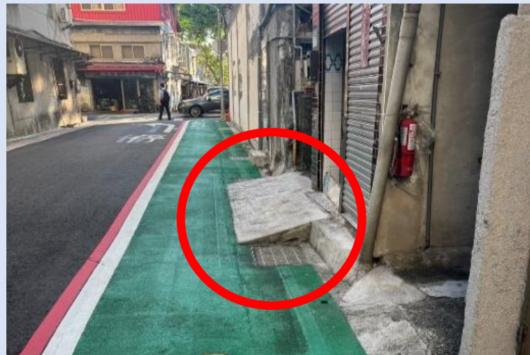
安東街5-2號-私設固定式斜坡道(改善後)
