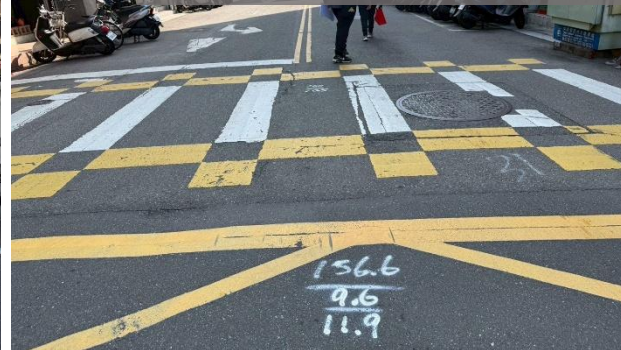
施工前 松山區八德路3段12巷51弄、52弄
