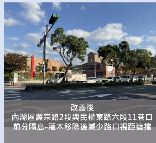
改善前 內湖區舊宗路2段與民權東路六段11巷口 前分隔島-灌木遮擋路口通行視距
