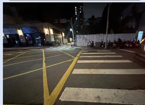
西園路一段、西園路一段72巷增設路燈-施工前
