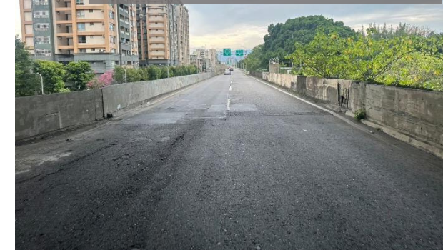
施工前 中正區水源快速道路(師大路至基隆路)
