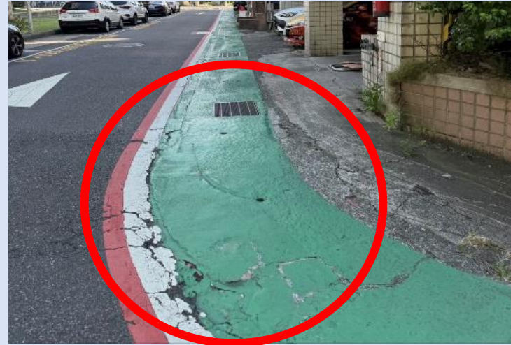
通河街1巷2號-鋪面破損(改善後)
