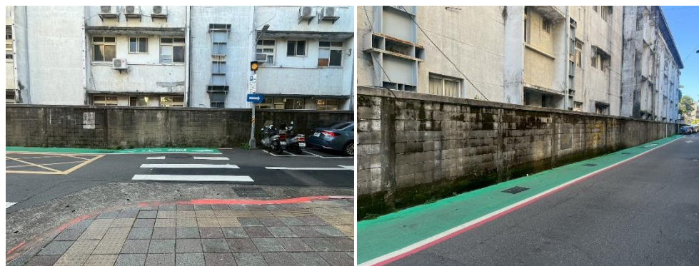
順平斜坡道、劃設行穿線、拓寬及加長標線型人行道 (延壽街356巷與330巷20弄口)
