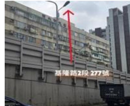
路燈桿遷移 基隆路二段277號
