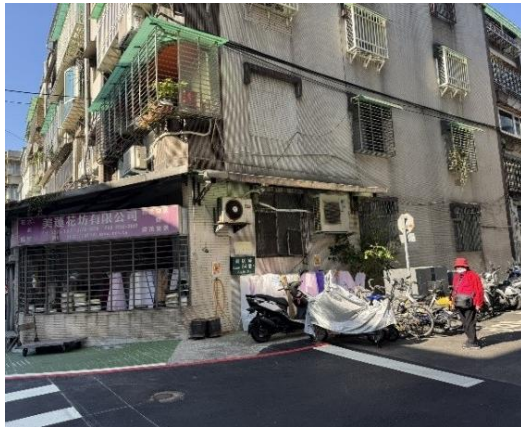
架空變電箱遷移 大安區安居街86號
