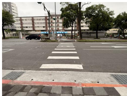
設置庇護島、退縮行穿線 (健康路-醫院門口)
