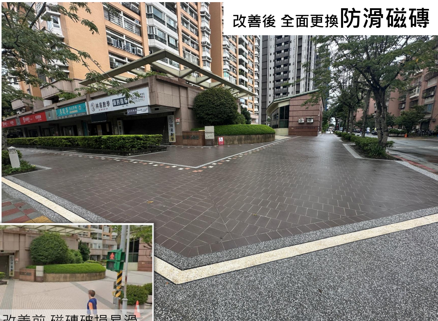
改善前 磁磚破損易滑
