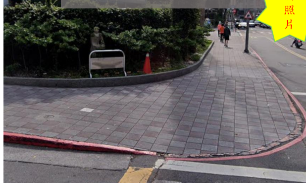
施工前 士林區天母國小行穿線調整與 斜坡道改善
