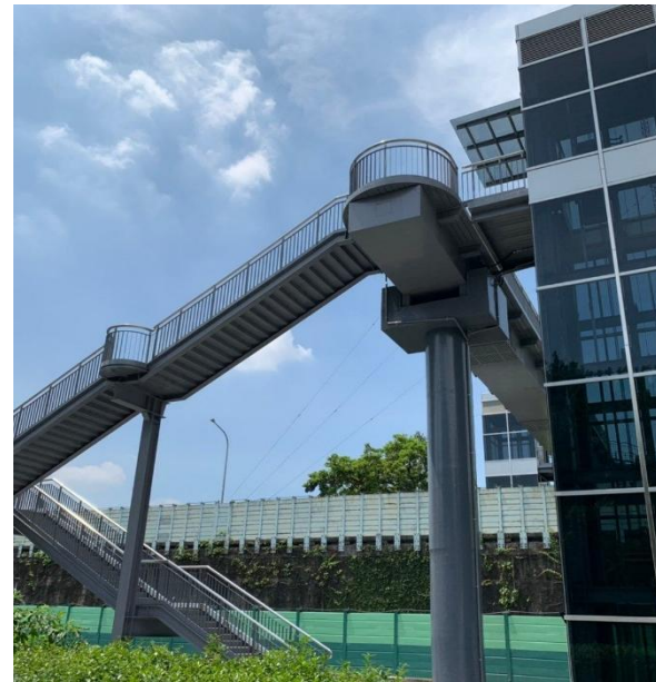
同安街跨堤天橋 無障礙設施(2022)
