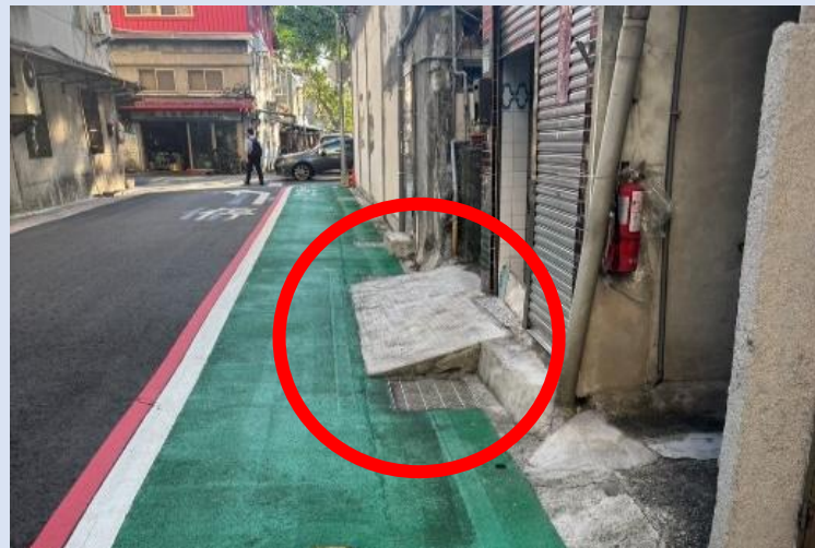
安東街5-2號-私設固定式斜坡道(改善後)
