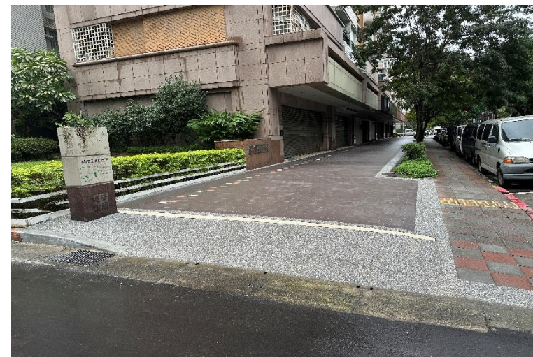
改善後 新設無障礙斜坡
