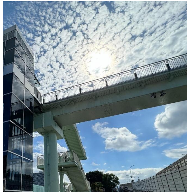
水源永春人行天橋 無障礙設施(2024)
