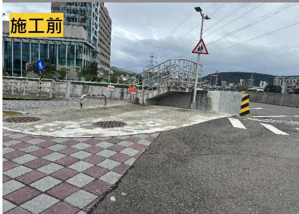
北投區建德橋西北側
