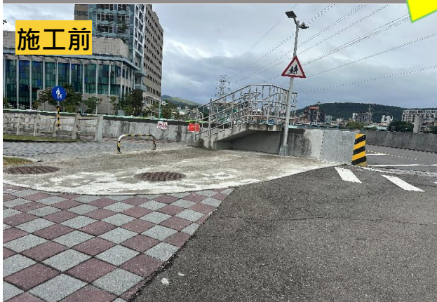
北投區建德橋西北側
