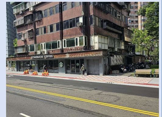
施工後(北側)人行道由1.5公尺拓寬為3公尺。
