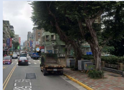
改善前 (河堤國小周邊路樹遮擋通行視距)
