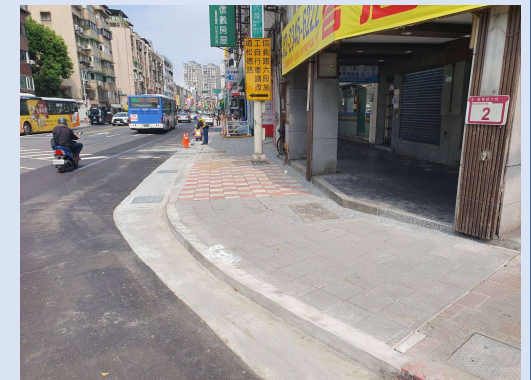
施工後(南側)人行道由1.5公尺拓寬為3公尺。
