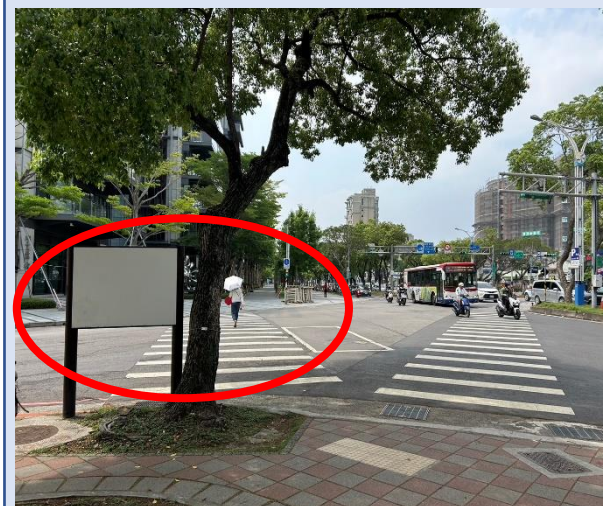
改善前 (福林路及中山北路四段交叉口，告示牌遮擋行穿線)
