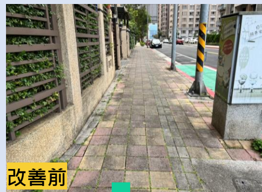
南港區重陽路 (沿街面人行空間)
