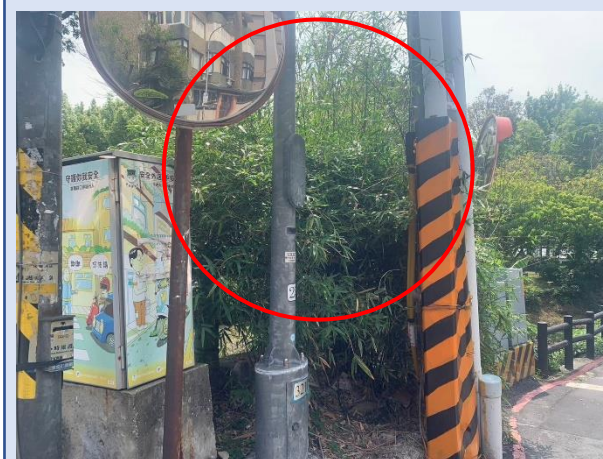
改善前 (復興一路及永興路二段交叉口)
