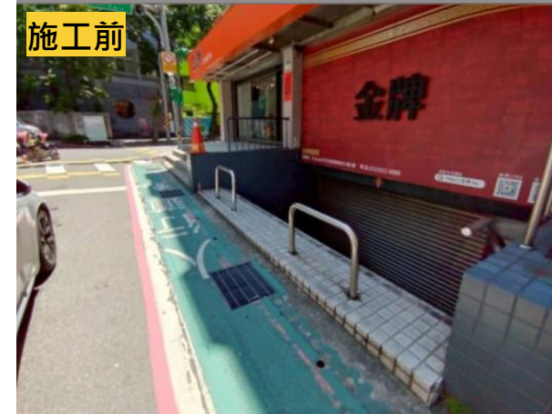
北投區實踐街 (致遠二路至實踐街83巷間)
