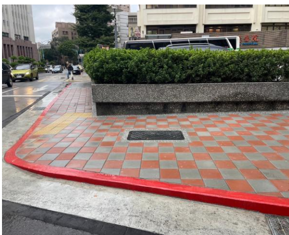
拓寬轉角人行道 (敦化北路與敦化北路199巷口)
