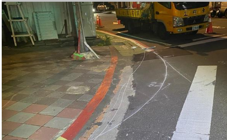
改善前-中正區泉州街(和平西路至8巷)
