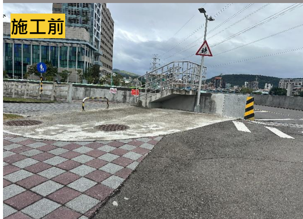
北投區建德橋西北側
