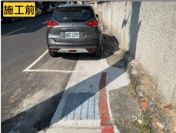
北投區中和街454號前 設置實體區隔工程
