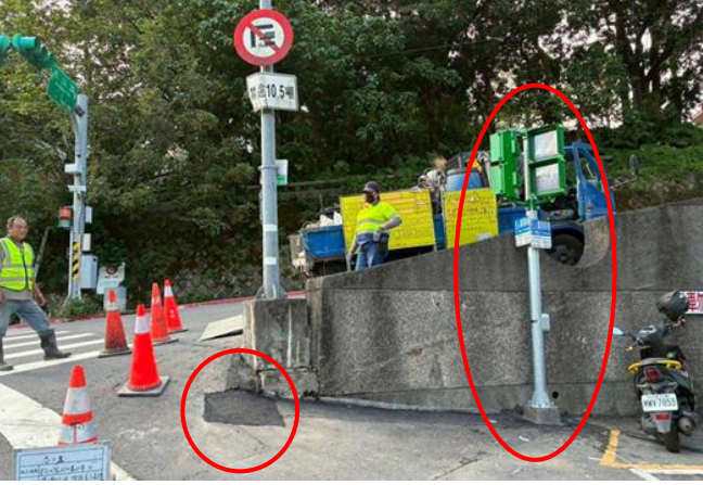
移設行人號誌桿 (松山路、松山路650巷15弄路口)
