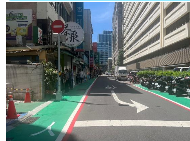
側溝更新、增設標線型人行道 (敦化北路199巷2弄東側)
