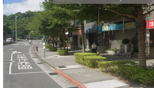
施工前 內湖區金湖路(330號至 326巷間)
