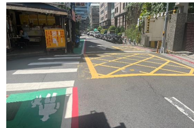
增設標線型人行道、行穿線 (敦化北路199巷2弄東側)
