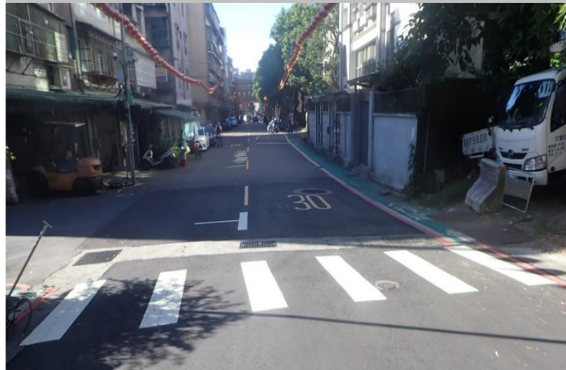
改善前-信義區福德街251巷與福德街251巷14弄
