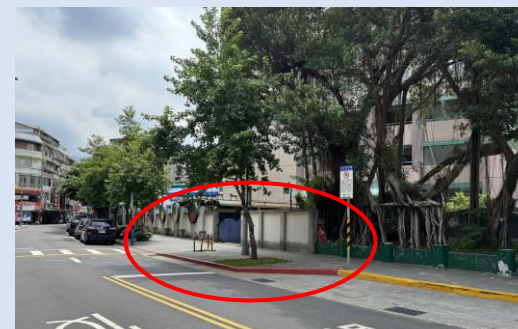
改善後 石牌國小周邊-人行道灌木阻擋路口視距 移除後減少視線遮擋
